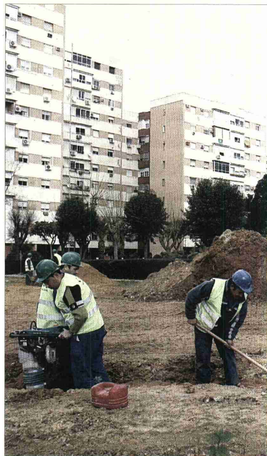
REURBANIZACIÓN. Operarios del Plan de Barrios en una de las obras.
