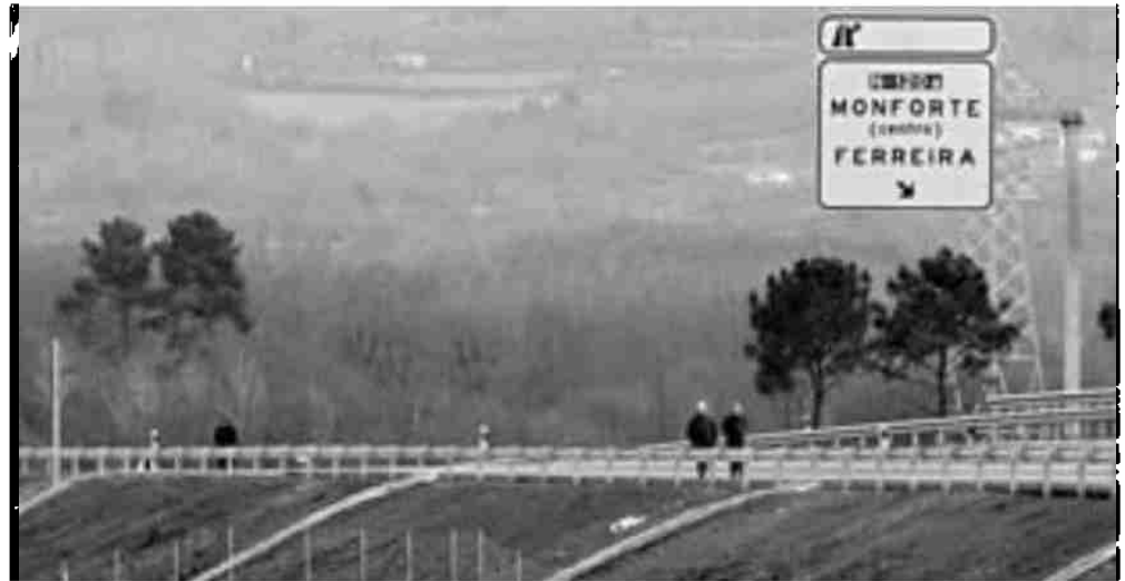
La variante entre la N-120 y la carretera de Chantada se completará con la circunvalación norte | ALBERTO LÓPEZ
