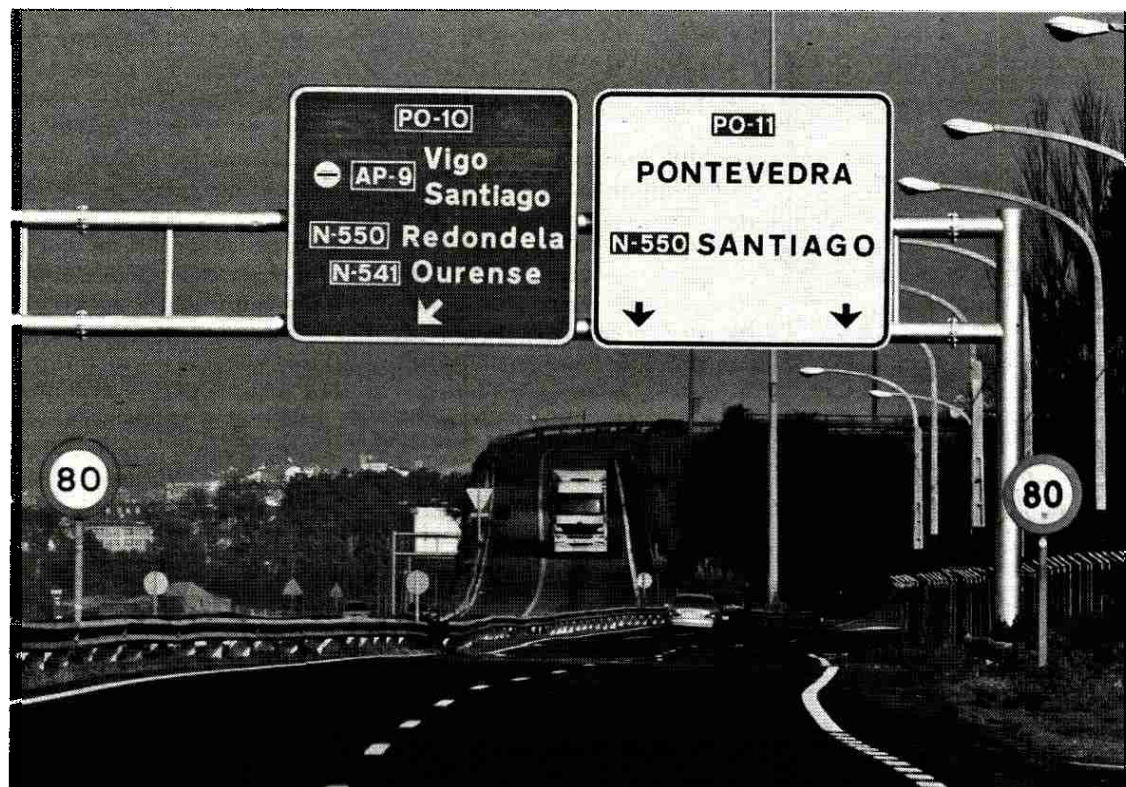
El tramo pontevedrés de la variante de la PO-546 conectará la nueva carretera con la Autopista del Atlántico y mejorará la seguridad vial de conductores y peatones. | RAFA FARIÑA
