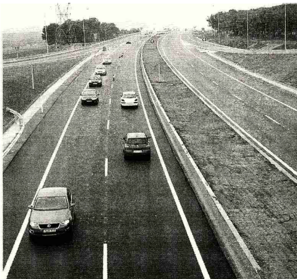
Imagen de un tramo de la A-68, con dos carriles ayer cerrados.
