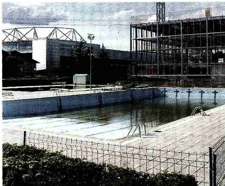
Aspecto actual de la piscina exterior de Mendizorroza. /J. ANDRADE
