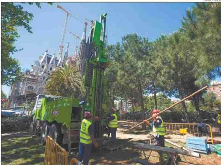
► Varios operarios realizan uno de los sondeos para el túnel del AVE en la calle de Mallorca, el pasado abril.
