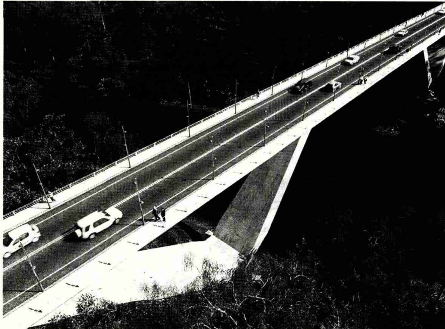
El puente quedará asentado sobre dos estructuras con forma "v". Una parte de la estructura se construirá 'in situ', y la otra vendrá lista para montar. | DEPUTACIÓN DE PONTEVEDRA
