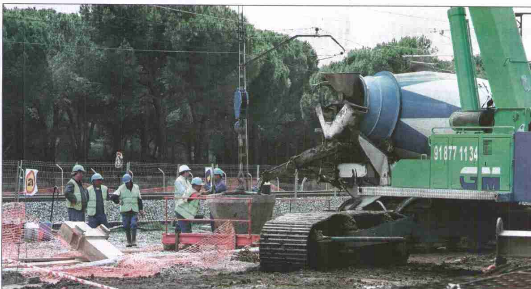
Varios operarios trabajaban ayer en las obras del Pinar con maquinaria pesada para la ejecución del primer muro pantalla para el túnel. / REPORTAJE GRÁFICO: J. M. LOSTAU
