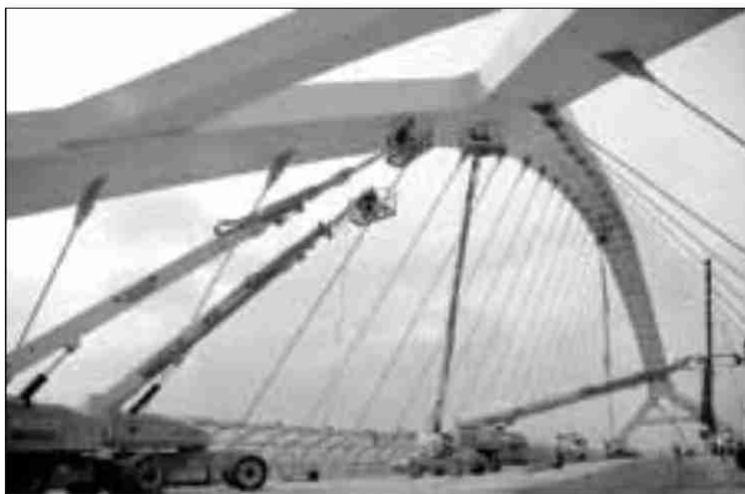
► El puente del Tercer Milenio, todavía en fase de acabados.
