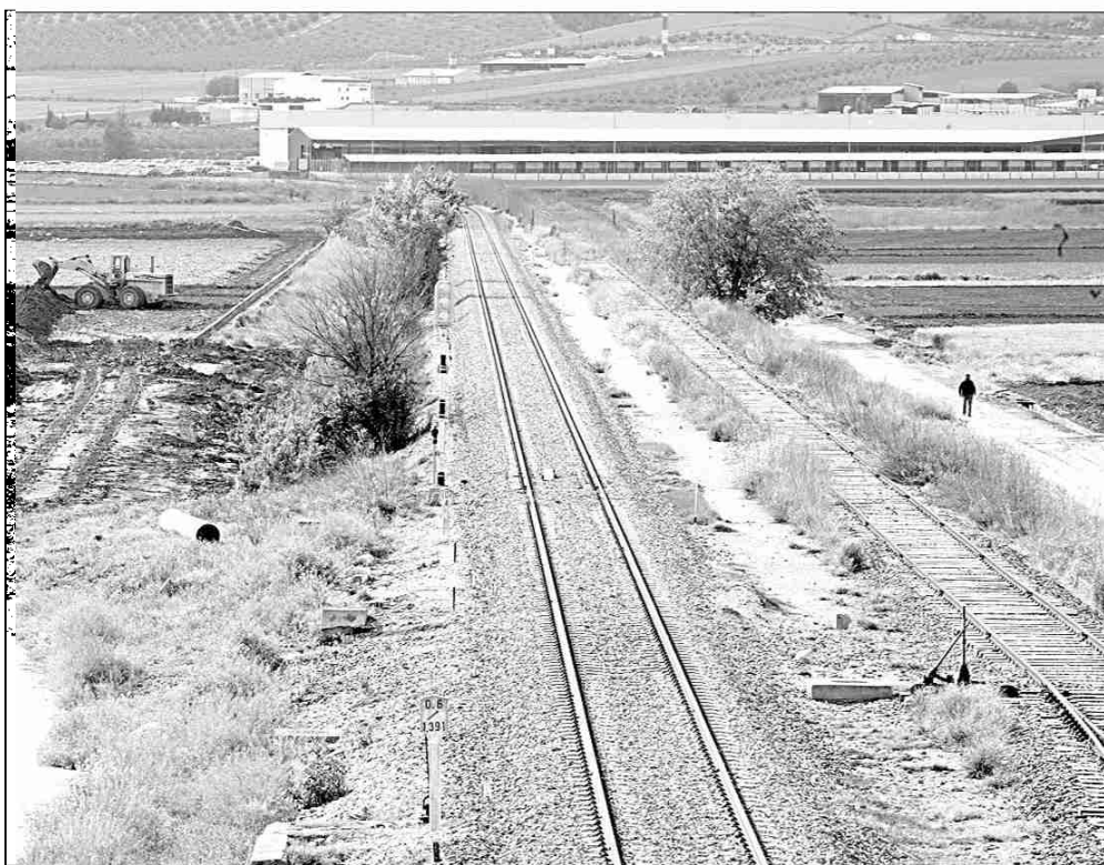
Obras. Línea de alta velocidad del tramo Antequera-Granada. J. P.
