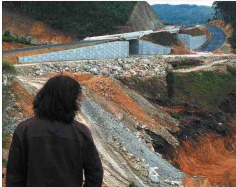
Obras en la carretera del puerto exterior de Ferrol a la altura de Cobas. / GABRIEL TIZÓN
