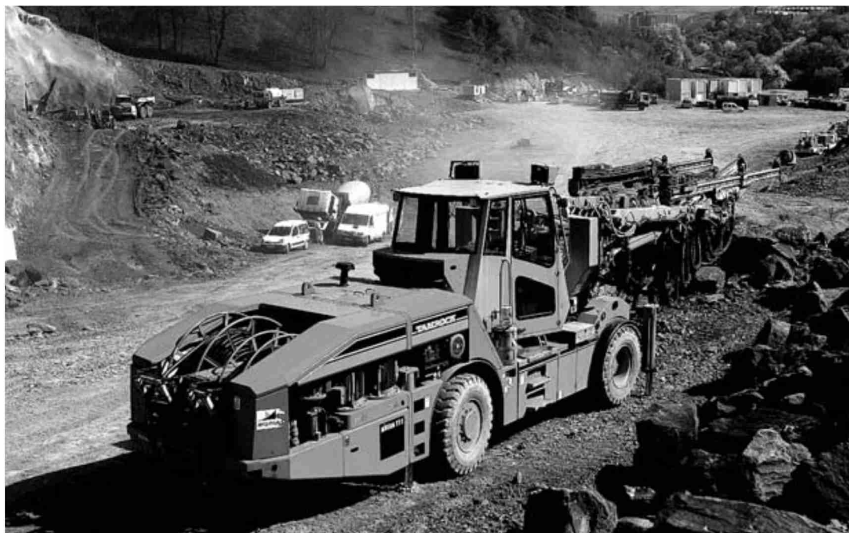
A TODA MÁQUINA. Una excavadora que horada los túneles se dispone a entrar en faena en uno de los tajos de la Supersur. A la derecha,
