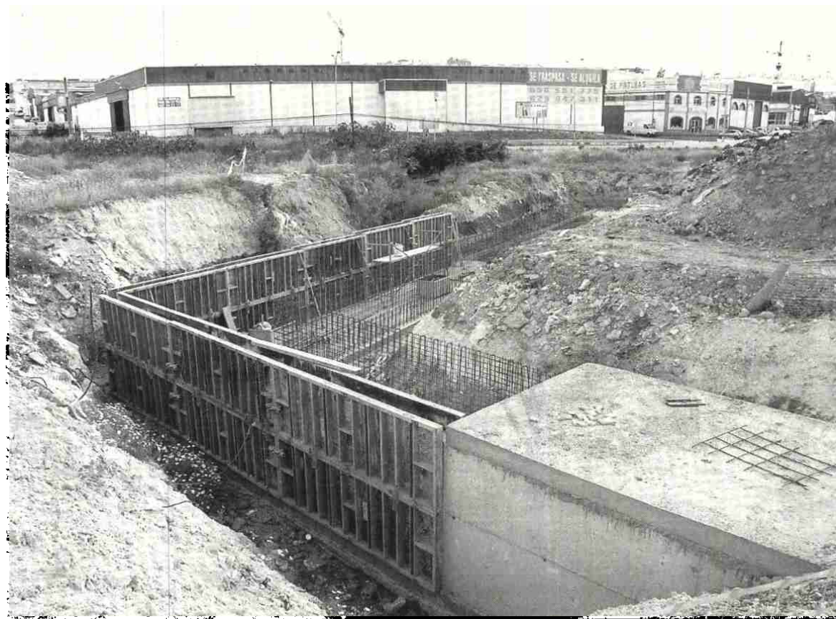
Aspecto que presentan las obras del nuevo colector que se está construyendo en terrenos de la futura Ciudad Deportiva de Huerta Mata.
