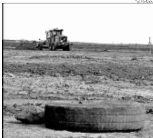
►► Obras del AVE en Guadalupe del Caudillo en noviembre del 2007.
