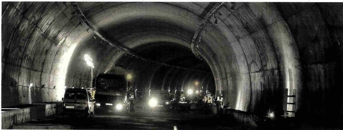
Imagen de unas obras en un túnel. EFE
