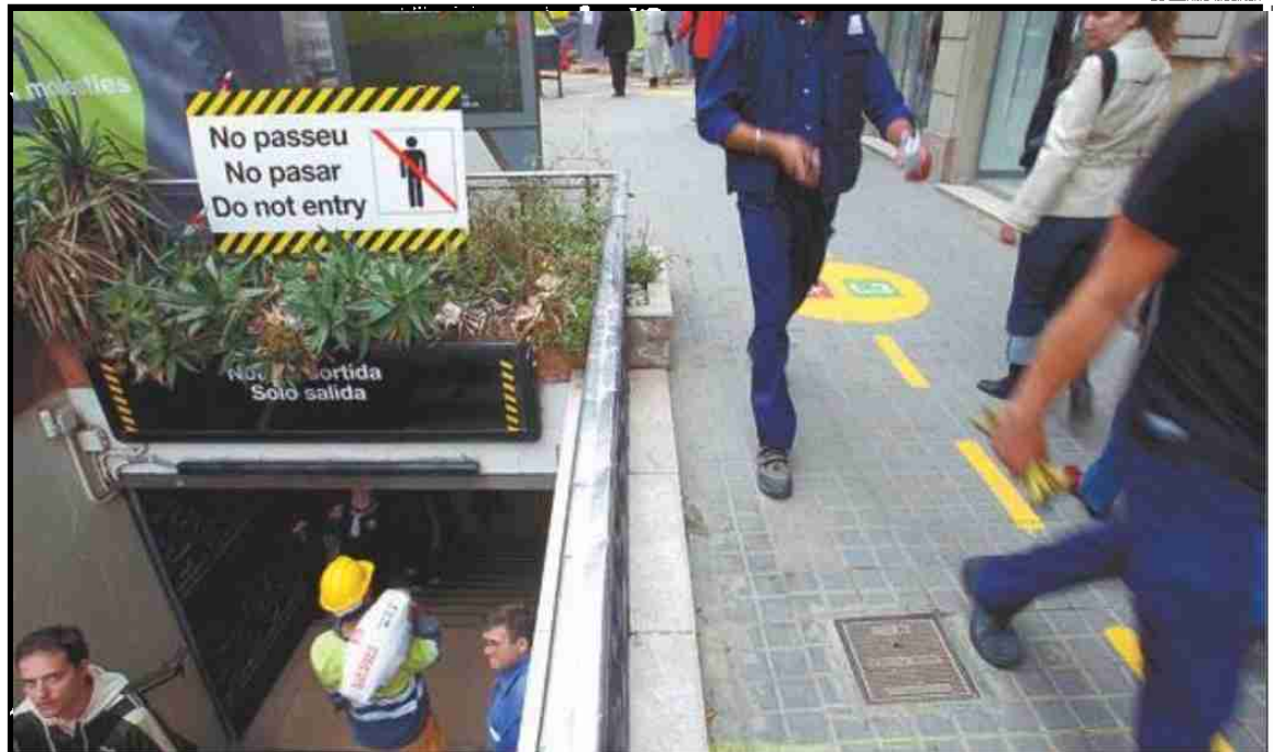
► Rambla de Catalunya ► Un trabajador de la obra entra en una boca que los pasajeros solo pueden usar para salir.
