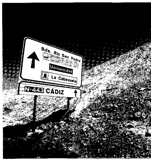
Obras del nudo del Río San Pedro, desde donde partirá el puente. JULIO GONZÁLEZ
