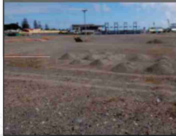
5 ROCÓDROMO: Las obras de este espacio multiusos ya han comenzado en la zona norte del Estadio de Gran Canaria.
