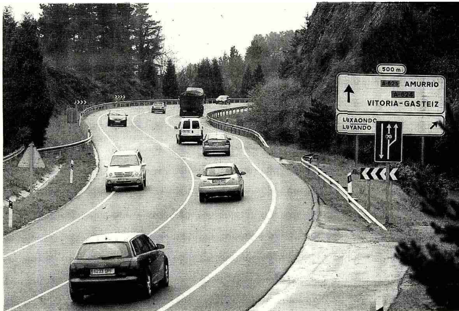
PLAN. Desdoblamiento de la carretera A-625 entre Llodio y Amurrio es una de las prioridades. / JOSÉ MONTES
