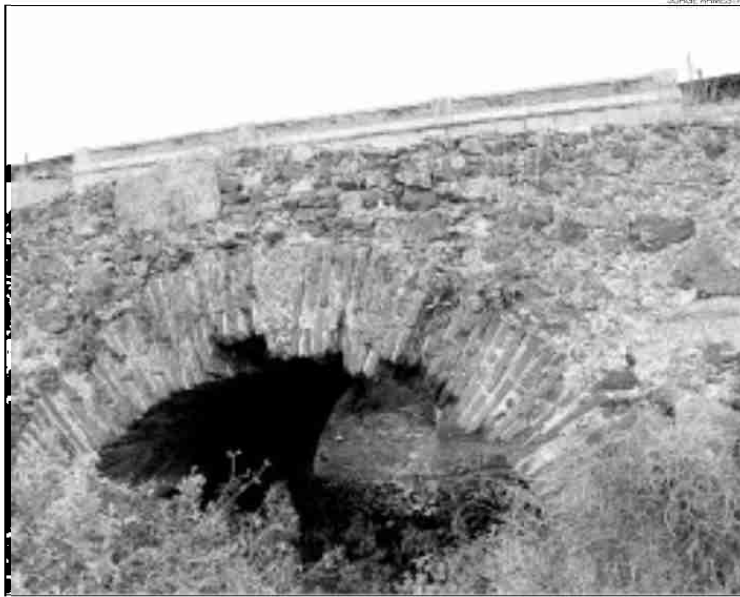
►► Puente romano de la alcantarilla, que se integraría en la estación al desplazarse las vías hacia arriba.
