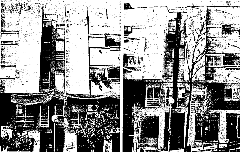
Intervenció en la façana principal al carrer Pla de Fornells, 17-19, Les Roquetes
