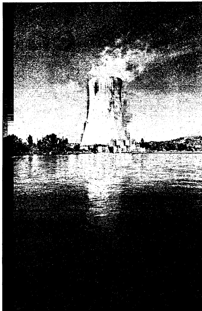
La torre de refrigeració d'Ascó reflectida sobre l'Ebre ■ TJERK VAN DER MEULEN
