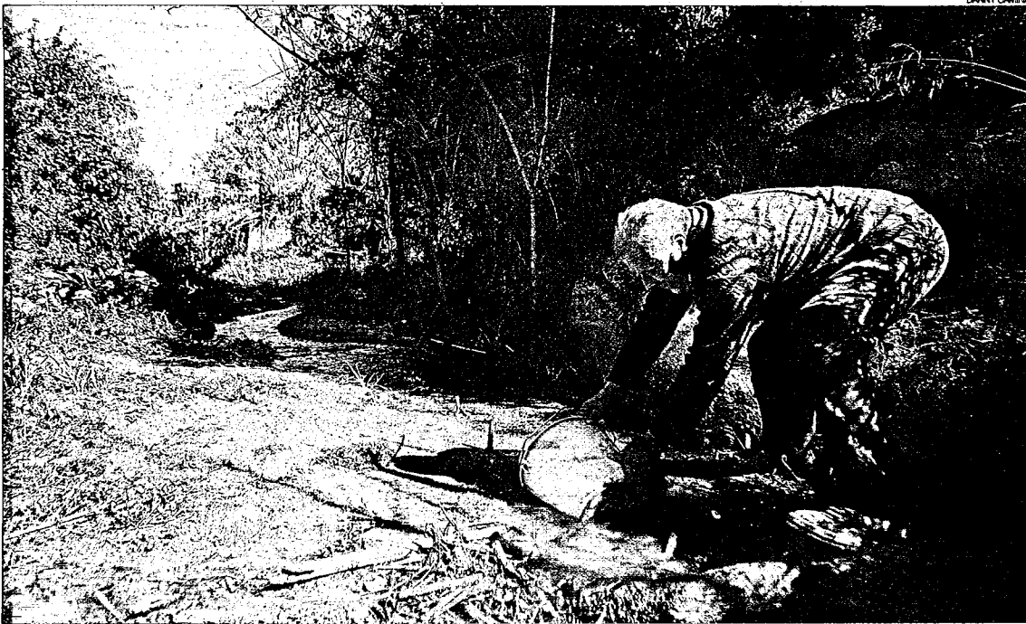
►► Un home omple una galleda amb l'aigua que es filtra de la conducció de Badalona, al barri del Canyet, ahir.
