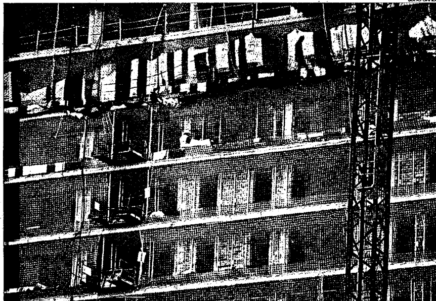
► Construcció de pisos a la carretera de Collblanc, a Barcelona.
