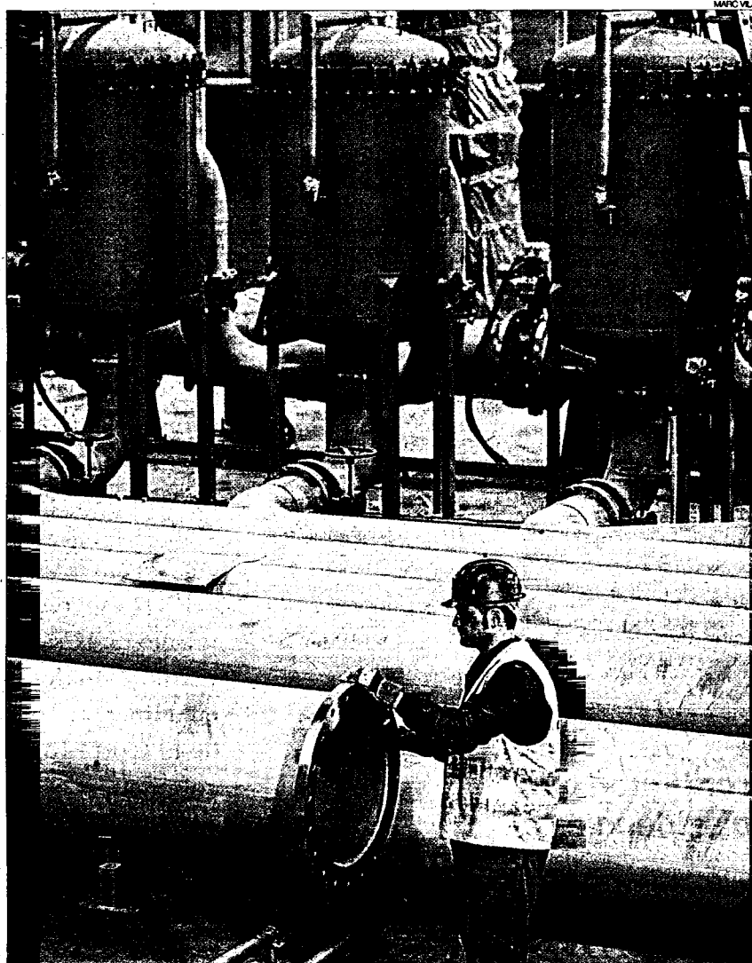
► Treballs d'ampliació de l'estació potabilitzadora d'Abrera, dimecres passat.
