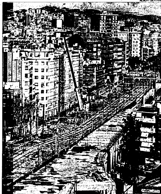
►► Obres de l'AVE a l'entrada a l'estació de Sants, ahir.
