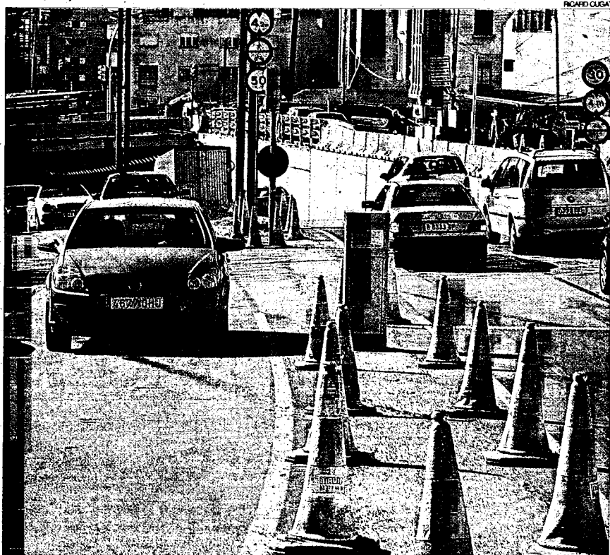
► La base d'una barrera d'accés, encara sense la barra, en una entrada al túnel de Lesseps, divendres passat.
