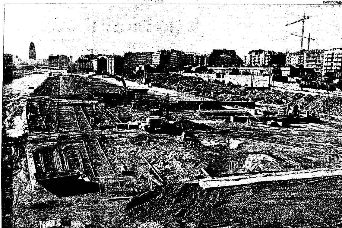
► El corredor de vies on hi haurà l'estació de la Sagrera, amb el pont de Calatrava al fons i les obres de les línies L-9 i L-4 del metro, ahir.
