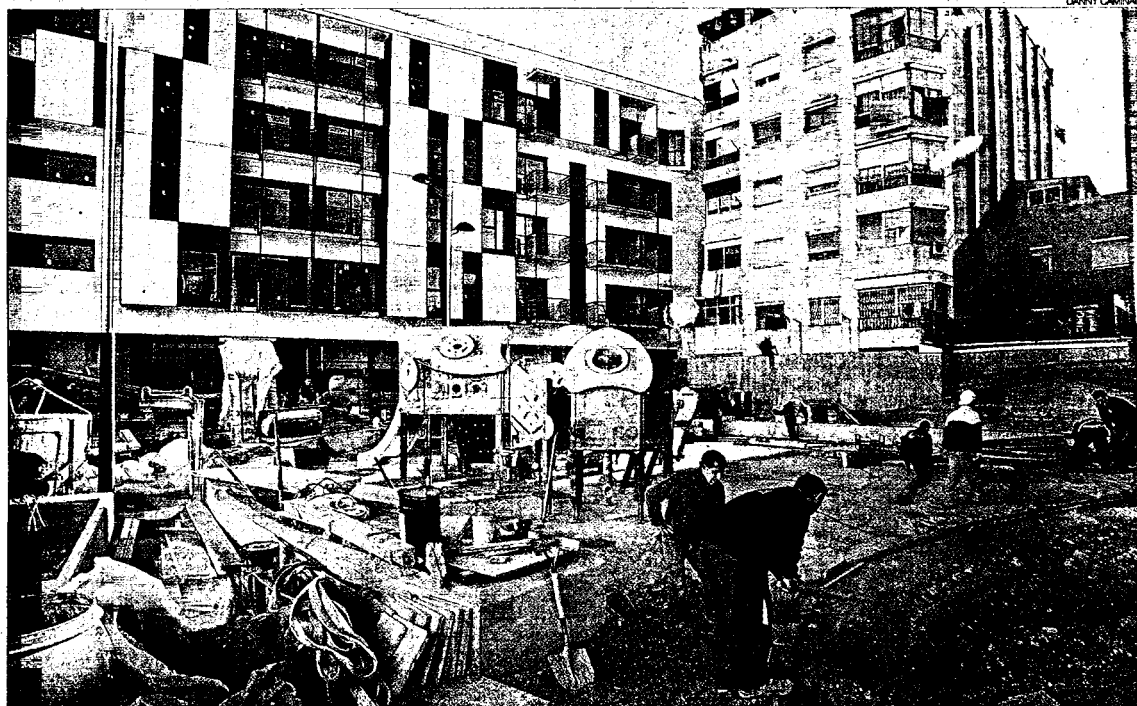
► Treballs de construcció de la zona verda interior de Vidrieres Llobregat, amb els nous pisos al fons, la setmana passada.
