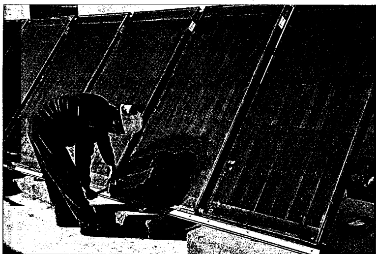
Un operario instalando placas solares térmicas en un edificio de Barcelona.
