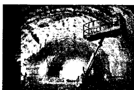
Acabada la perforació, comencen els treballs de drenatge ■ CLICK ART
