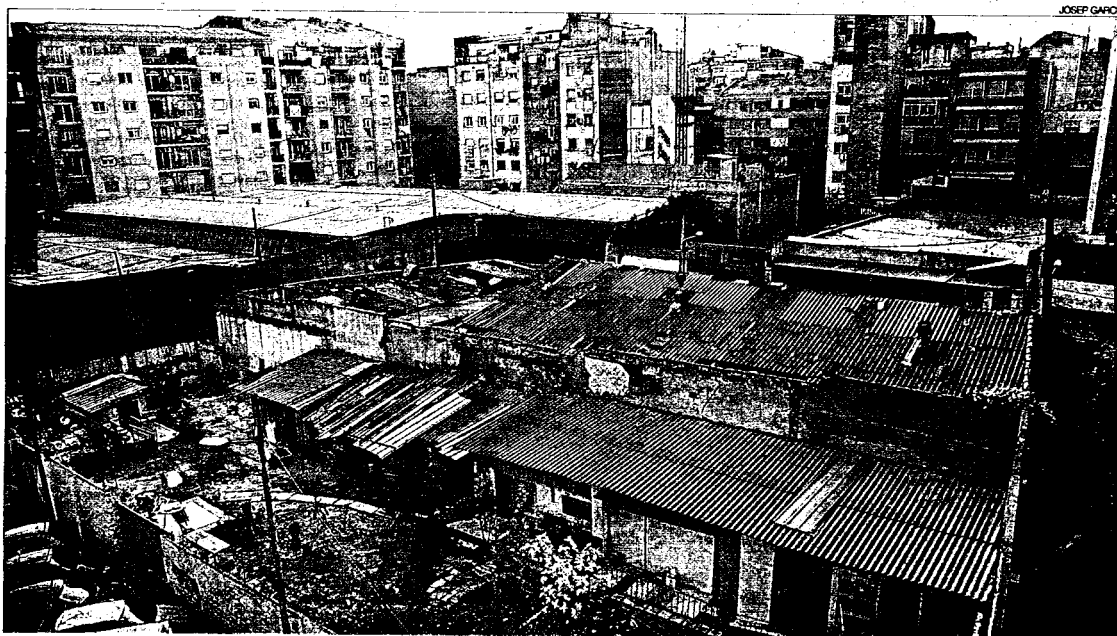
► Edificacions que seran enderrocades per reurbanitzar l'eix de Juan de Sada, a Sants.
