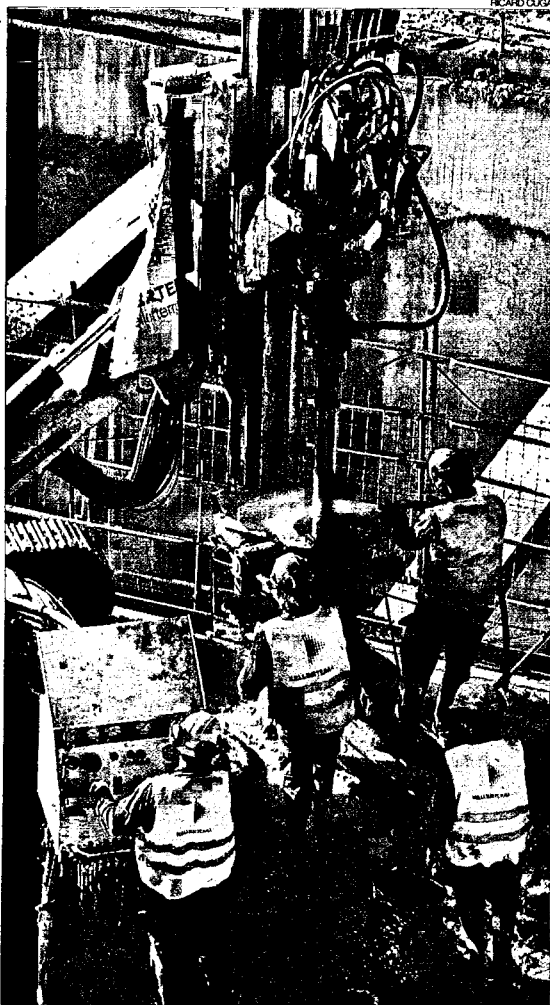
► Una màquina comprova l'estat del subsòl, ahir, a Bellvitge.
