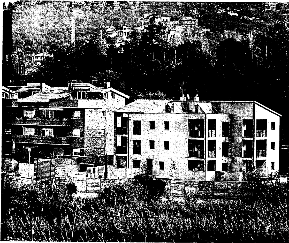
Un dels edificis promogut per l'Incasòl, a Torrelles de Llobregat.
