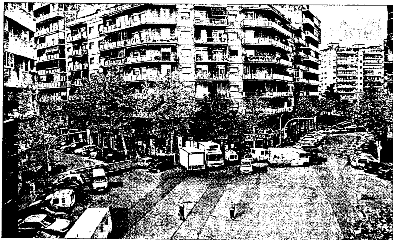
Esquina de la calle de Honduras donde se construirá una estación de la línea 9 del metro. / CONSUELO BAUTISTA
