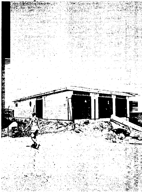
La caseta de transformación en Blanes, descalzada por los temporales.
