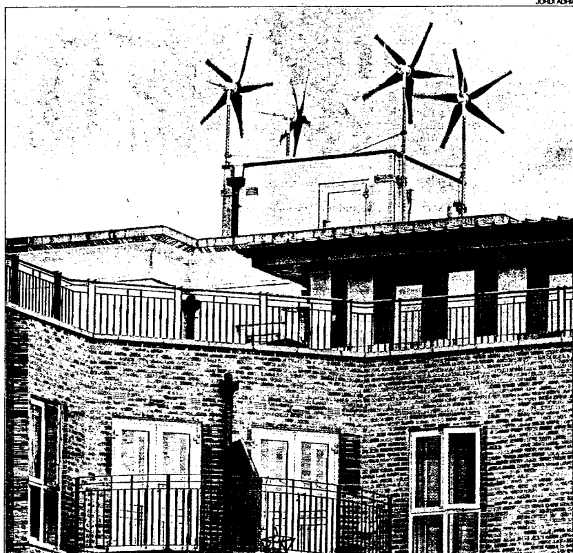
►► Molins instal·lats en un edifici de vivendes al barri londinenc de West Kensington.
