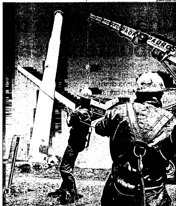
►► Diversos operaris desmunten els molins de vent, ahir, a Roses.
