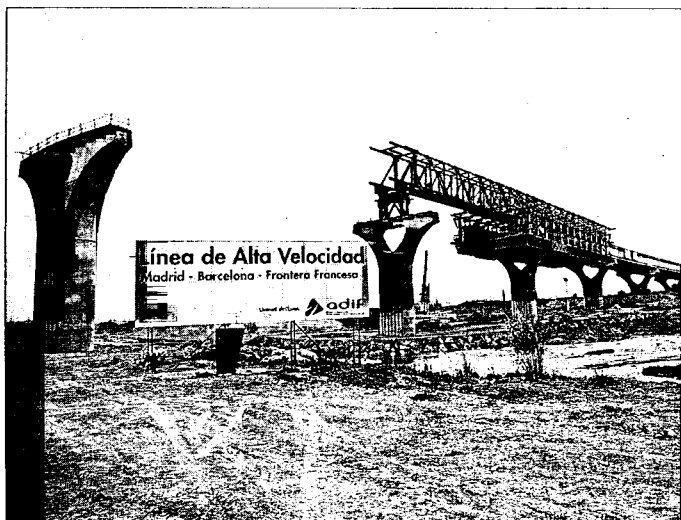
Obras en la línea de Alta Velocidad ferroviaria (AVE), Madrid-Barcelona-Frontera Francesa. / Efe
