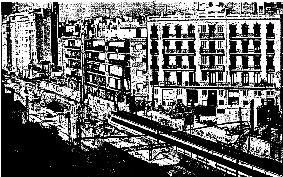
Aspecte actual de les obres del TGV al seu pas pel barri de Sants, al carrer d'Antoni Capmany ■ XAVIER BERTRAL
