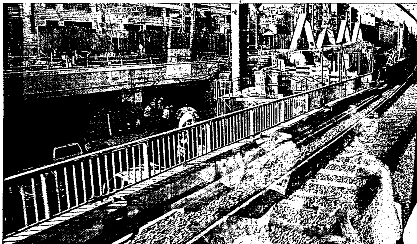
► Obres de l'alta velocitat a Sants, a l'altura de l'estació de metro de Mercat Nou, ahir.
