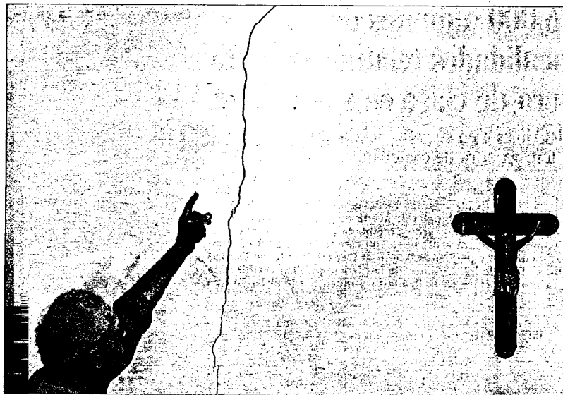
Un vecino muestra una grieta en una vivienda de la calle de Ignasi Iglesias. / CARMEN SECANELLA
