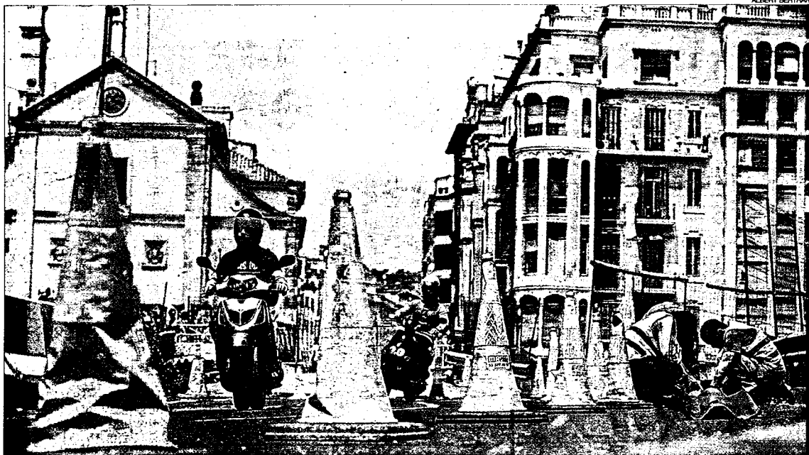
►► Uns operaris treballen al carril tancat al trànsit al costat de la plaça de Lesseps, ahir.
