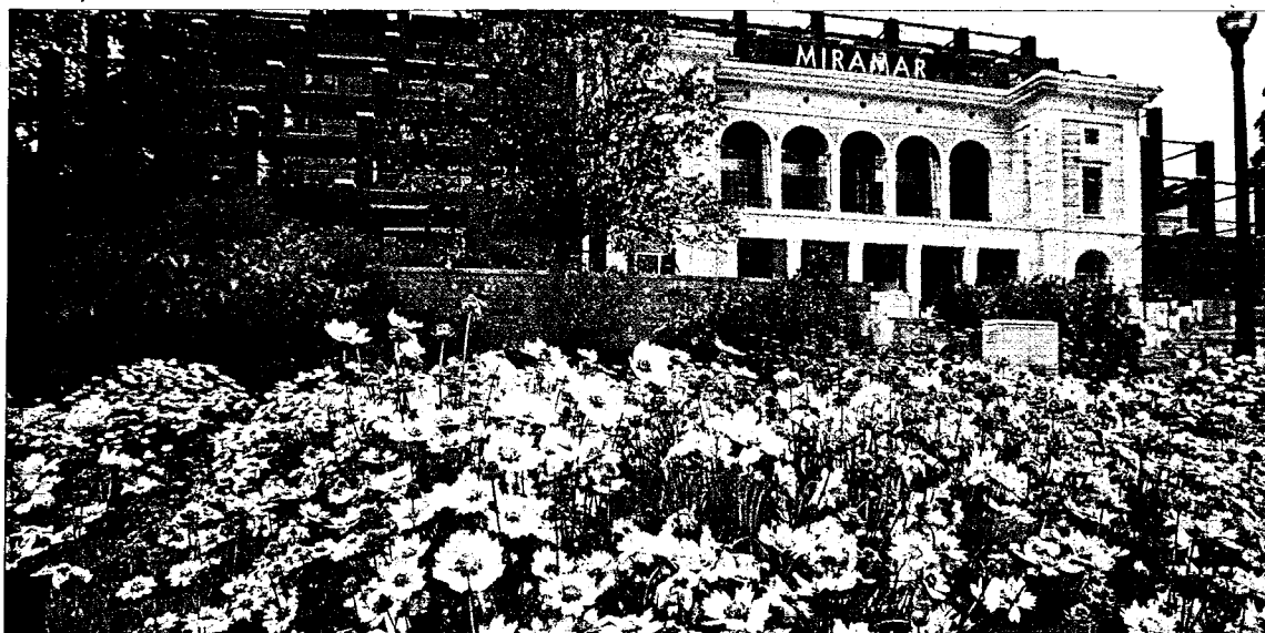
El nou Hotel Miramar de Montjuïc ha conservat només la façana de l'edifici que es va construir el 1929 i on durant 30 anys hi va haver els estudis de TVE ■ J. LOSADA
